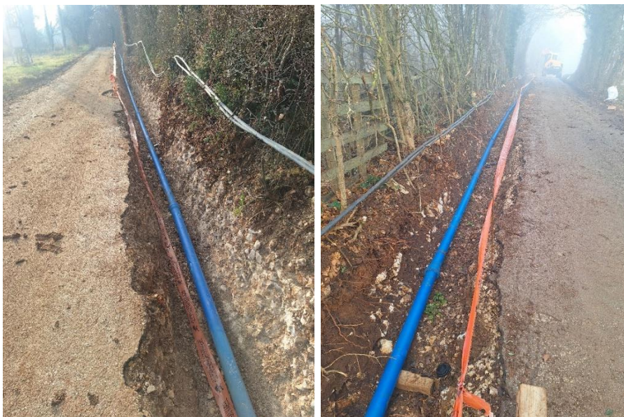
SLIKA 10. RADOVI U NASELJU BLAŠKOVIĆI
