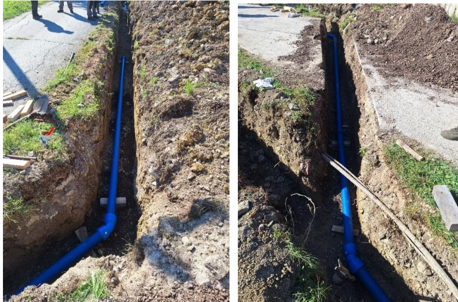
Slika 11. Radovi u naselju Jakomići
