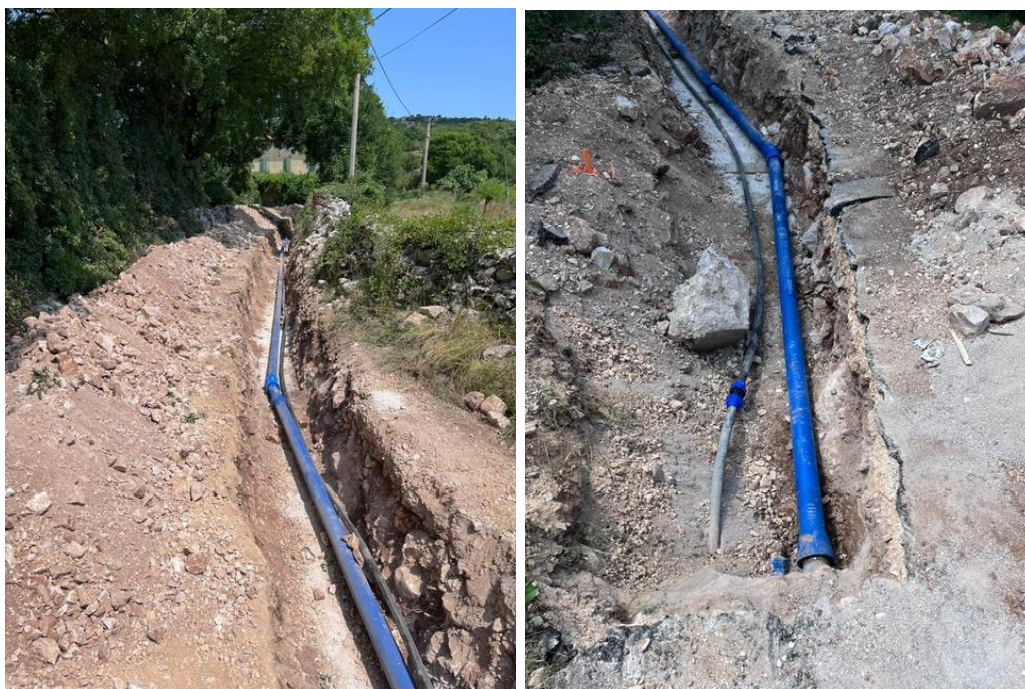
SLIKA 7. POSTAVLJANJE CJEVOVODA NASELJA DROPINI
